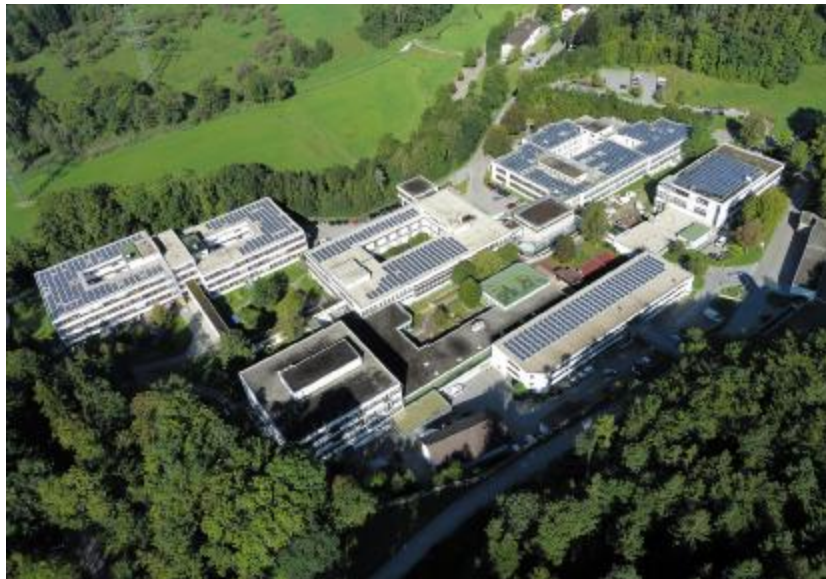
图为中盛光电奥地利项目
