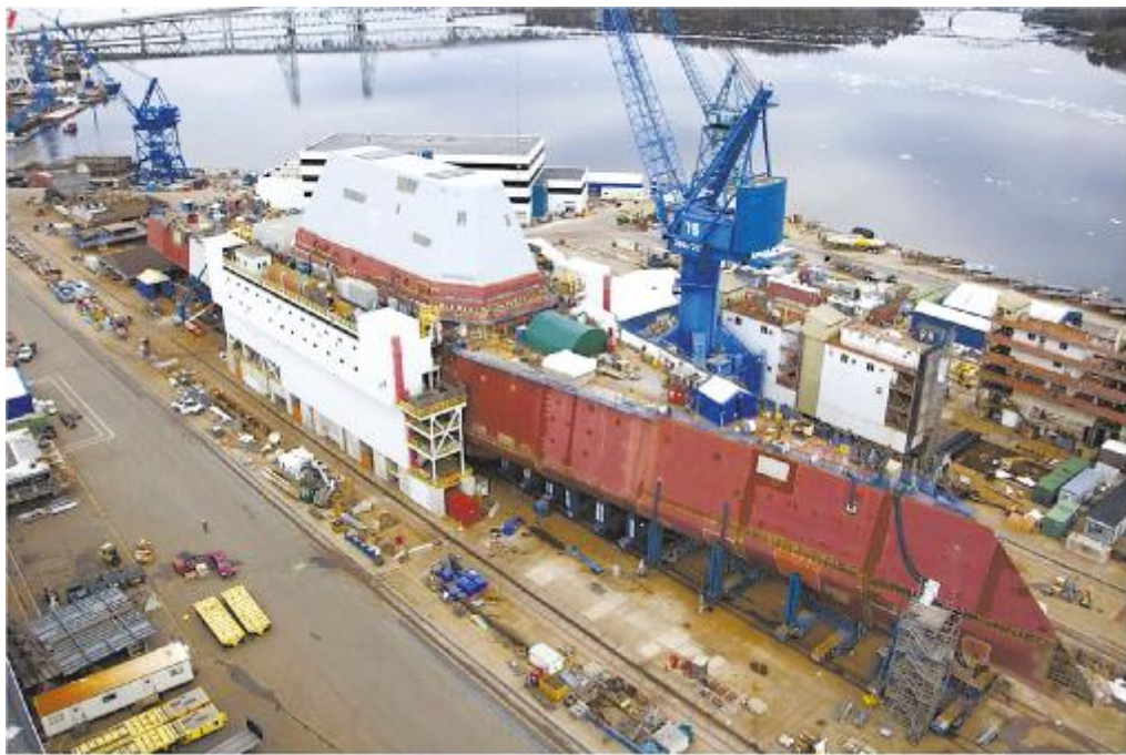
DDG-1000 驱逐舰“朱姆沃尔特”在位于美国缅因州肯尼贝克河畔的巴斯钢铁造船厂组装。 图片来源:百度图片
