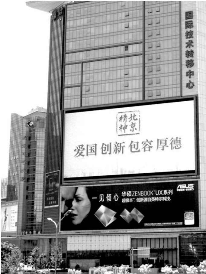
随着技术转移工作的重要性日益为人们所认识,各地纷纷设立技术转移中心。图为位于北京中关村的国际技术转移中心。
