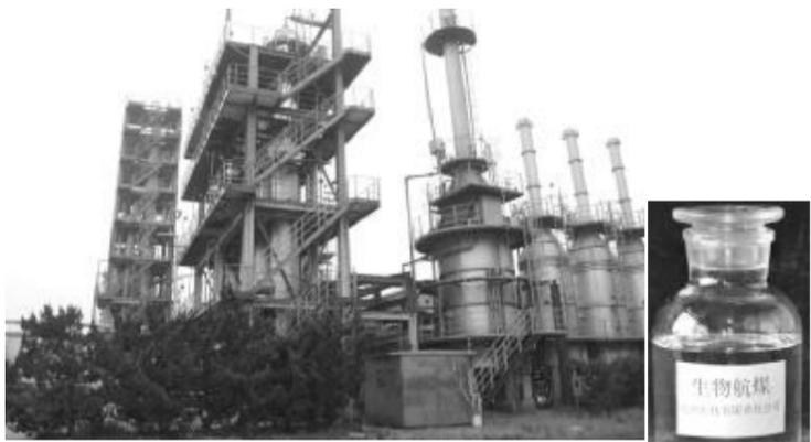
▲中国石化将杭州炼油厂加氢装置改造用于生产生物航煤
