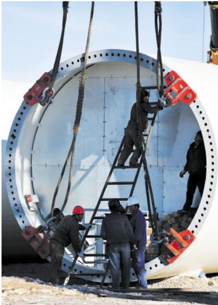
12月8日,施工工人正在准备吊装3兆瓦风机塔筒。在我国首个千万千瓦级风电基地——酒泉风电基地,由大唐甘肃新能源公司建设的国产3兆瓦风电示范塔筒正在施工。目前,已经在玉门昌马风电场安装80台3兆瓦风机的塔筒,装机容量达到了24万千瓦。
