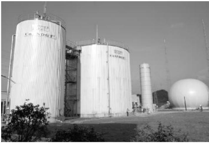
利用厌氧消化技术可将污泥分解成二氧化碳、甲烷和水,最终实现节能减排。中持绿色供图
