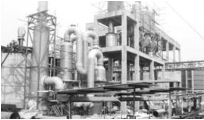
建设中的磷酸生产线
