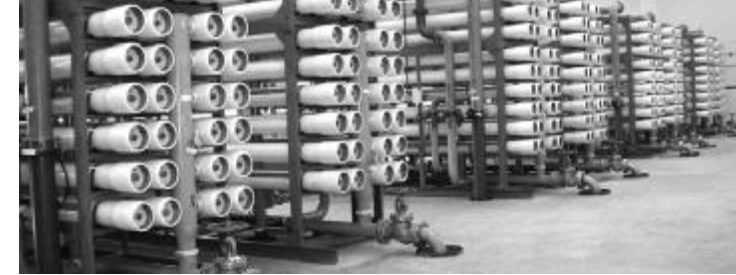
全球经济的持续下滑或导致高性能膜相关投资低于预期。图为海水淡化反渗透膜设备。图片来源:digude.com
