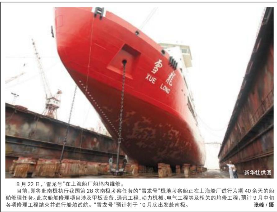
8月22日,“雪龙号”在上海船厂船坞内维修。目前,即将赴南极执行我国第28次南极考察任务的“雪龙号”极地考察船正在上海船厂进行为期40余天的船舶修理任务。此次船舶修理项目涉及甲板设备、通讯工程、动力机械、电气工程等相关的坞修工程,预计9月中旬各项修理工程结束并进行船舶试航。“雪龙号”预计将于10月底出发赴南极。
