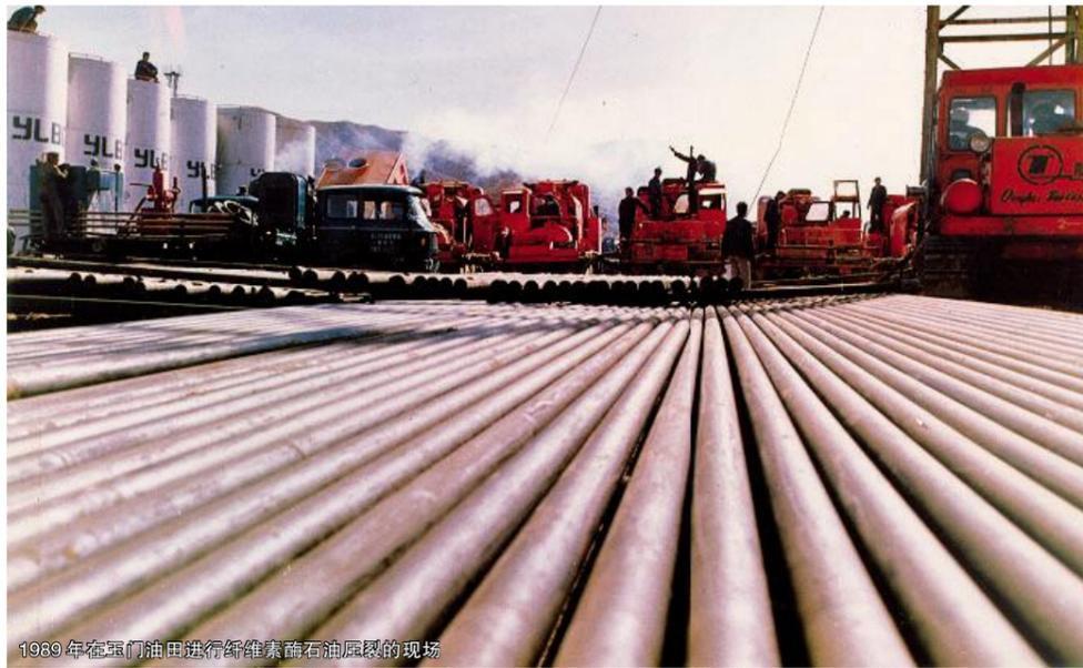
1989年在玉门油田进行纤维素酶石油压裂的现场
