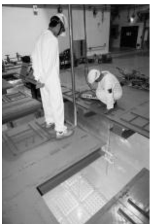
中国实验快堆乏燃料贮存水池
