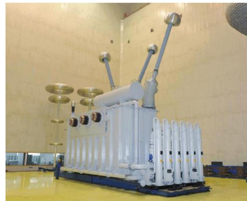
我国容量最大的水冷却式变压器下线
