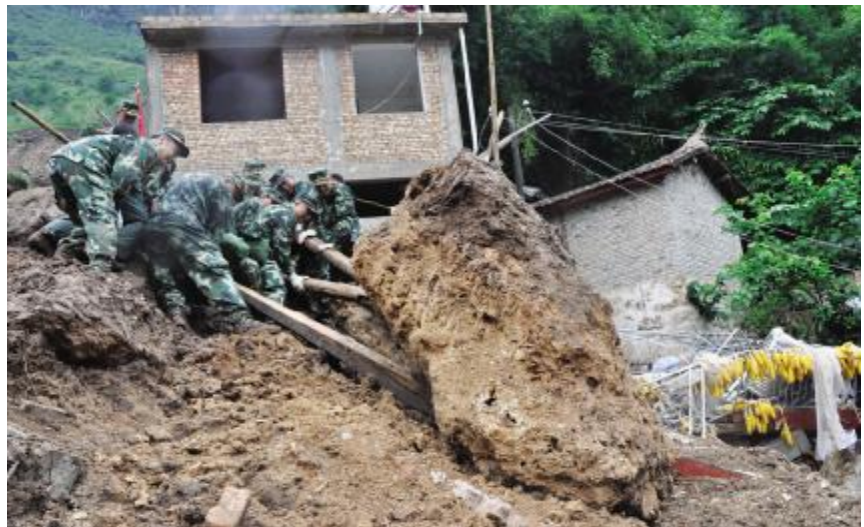
9月2日, 云南保山公安边防支队赴马乡抢险救援突击队官兵用木棒撬起一块巨石。 9月1日23时左右, 云南省保山市隆阳区瓦马乡东村大石房村民小组发生山体滑坡灾害。截至9月2日10时统计, 灾害已造成4人死亡、44人失踪, 有23人获救生还。具体灾情还在进一步统计核实中。 新华社供图
