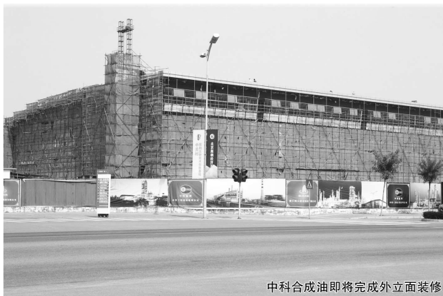
中科合成油即将完成外立面装修
