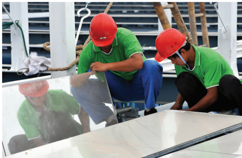
皇明员工正在安装“太阳能工厂”
