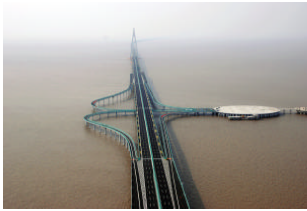
桥景结合是杭州湾跨海大桥工程的一大闪光点。该大桥在设计中首次引入了景观设计的概念。图为杭州湾跨海大桥的海中平台。
