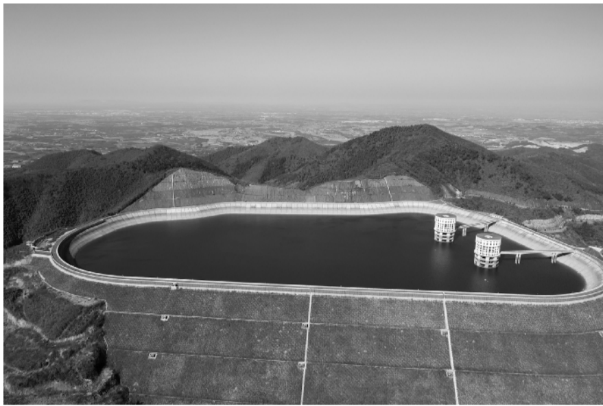
江苏溧阳抽水蓄能电站
