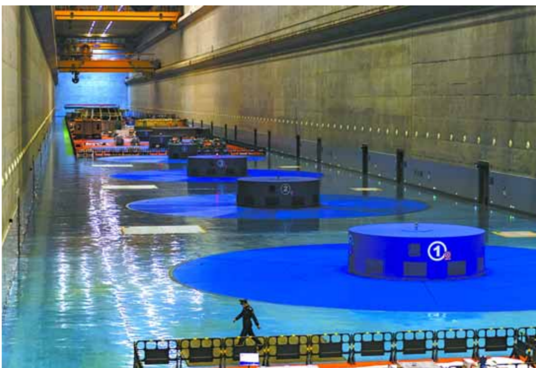
截至 2020 年 12 月 31 日 24 时,在确保三峡工程全面发挥防洪、航运、水资源利用等综合效益的前提下,三峡电站 2020 年全年累计生产清洁电能 1118 亿千瓦时,打破了此前南美洲伊泰普水电站于 2016 年创造并保持的 1030.98 亿千瓦时的单座水电站年发电量世界纪录。图为 2020 年 12 月 31 日晚拍摄的三峡左岸电站厂房。
