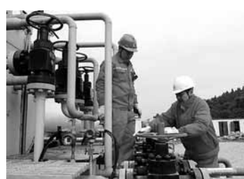
员工正在进行新井设备维护保养。
