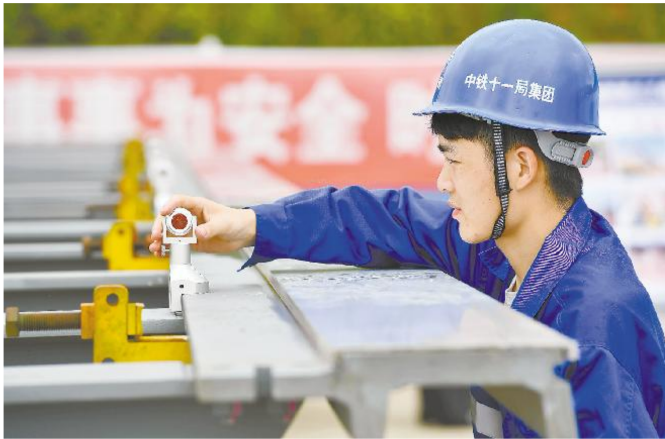
8月5日,中铁十一局技术员在清远磁浮轨排基地的试验梁轨排上放置精调棱镜。
