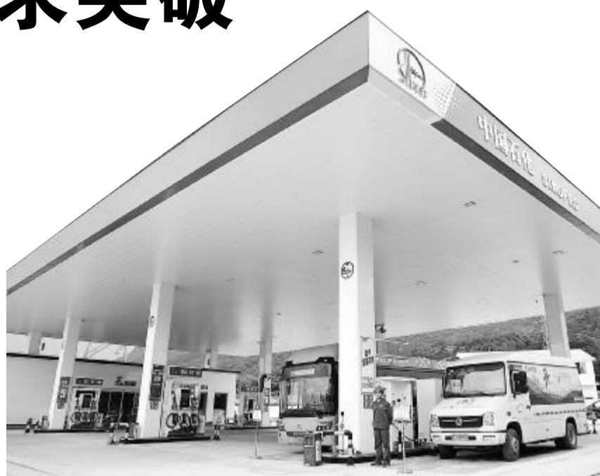
全国首座油氢合建站——佛山樟坑油氢合建站。
