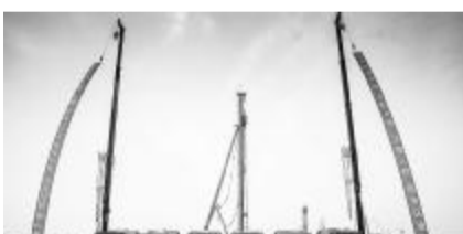
中俄东线天然气管道南段长江盾构穿越工程开工现场
