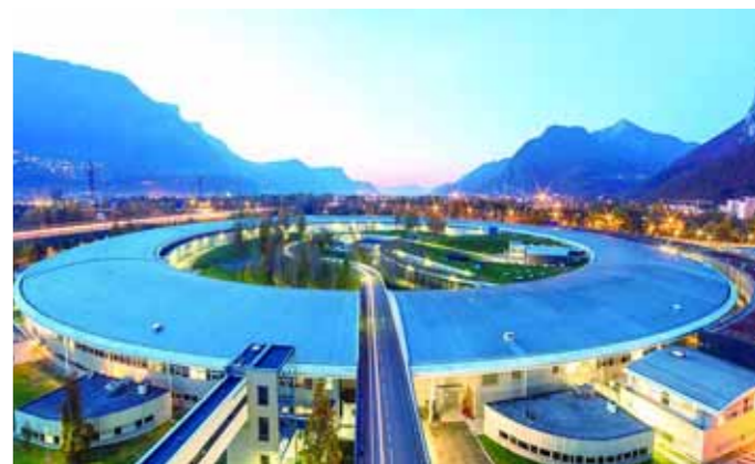
位于法国格勒诺布尔的环形同步加速器大楼 图片来源: ESRF/P.Jayet
