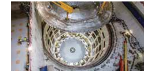
起重机将ITER的杜瓦底座吊入托卡马克基坑内。图片来源：ITER组织
