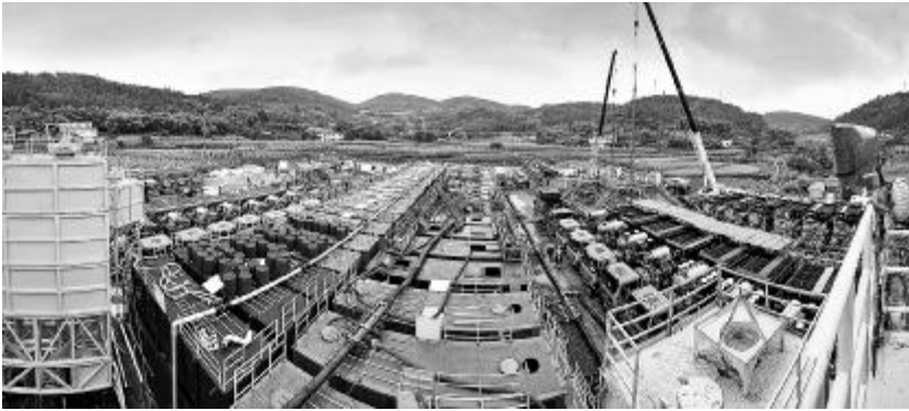
2014 年 8 月 14 日,涪陵工区规模最大、设备使用最多、合计压裂层数最多、注入总流量最大的一次井工厂同步压裂施工,在焦页 42 号平台正式启动。
