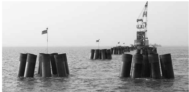
杭州湾跨海大桥钢管桩
