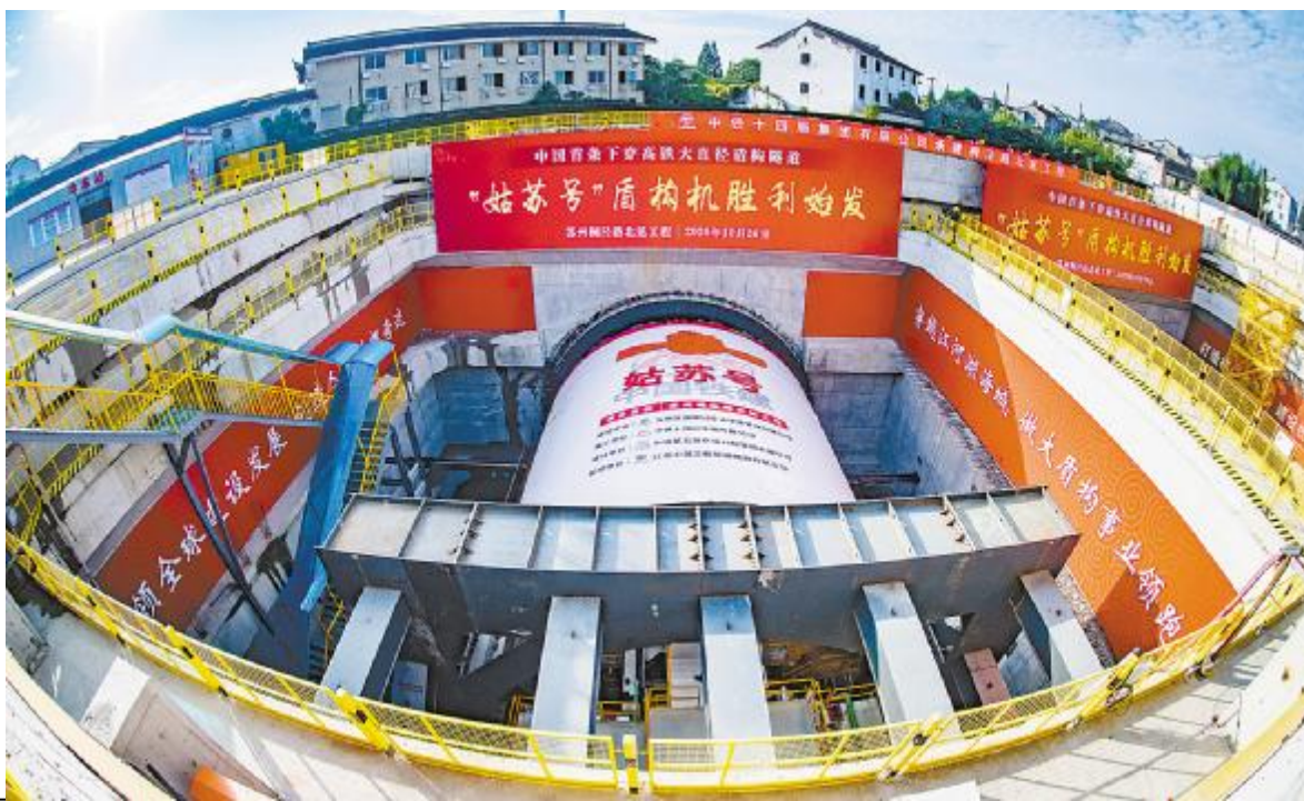
10月26日,由中铁十四局集团承建的苏州市桐泾路隧道开始盾构掘进。这是目前我国首条下穿运营高速铁路的大直径盾构隧道。该隧道设计为双洞六车道城市主干道,行车时速60公里。隧道单洞长490米,盾构机开挖直径13.67米。洞内布置为上下两层,上层为车道层,下层为疏散通道及管线通道。新华社发
