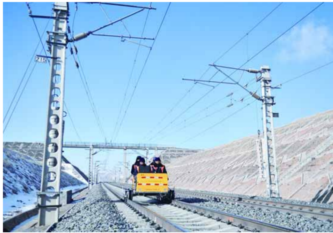
1月16日,青藏铁路公司西宁工务段探伤车间工人操作双轨式钢轨超声波探伤仪在青藏铁路海晏至青海湖区间进行检测。
