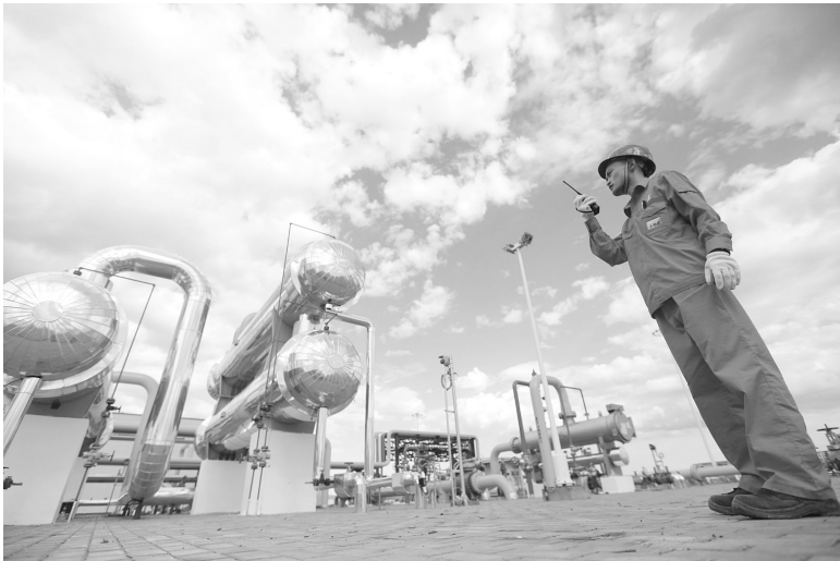
东胜气田一期天然气处理站建设过程中，建设者在指挥安装。
