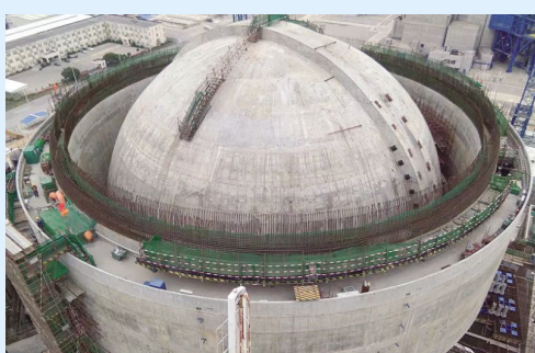
外穹顶脚手架搭设
