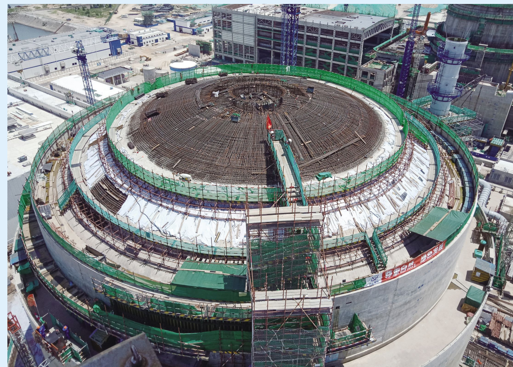
外穹顶钢筋绑扎
