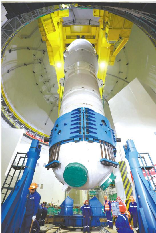
图为“华龙一号”示范工程福清6号机组第三台蒸汽发生器吊装就位。马建伟摄
