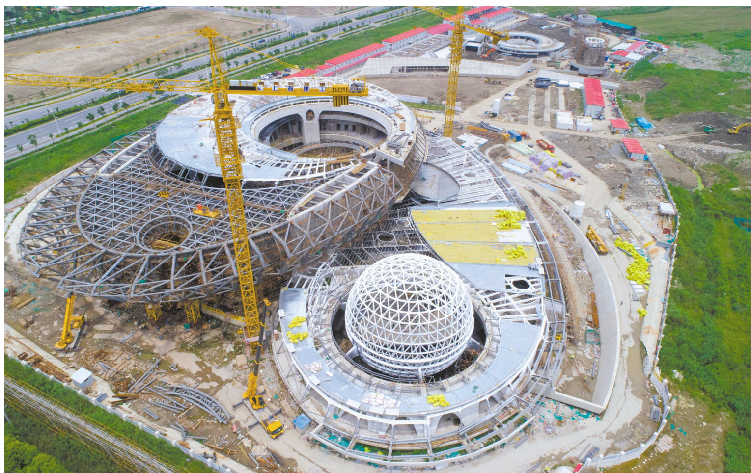
6 月 12 日，随着桁架间补缺杆安装及焊接工作的完成，上海天文馆（上海科技馆分馆）用钢量达 2000 多吨的大悬挑结构整体卸载。这标志着上海天文馆所有主体钢结构工程顺利收尾。
