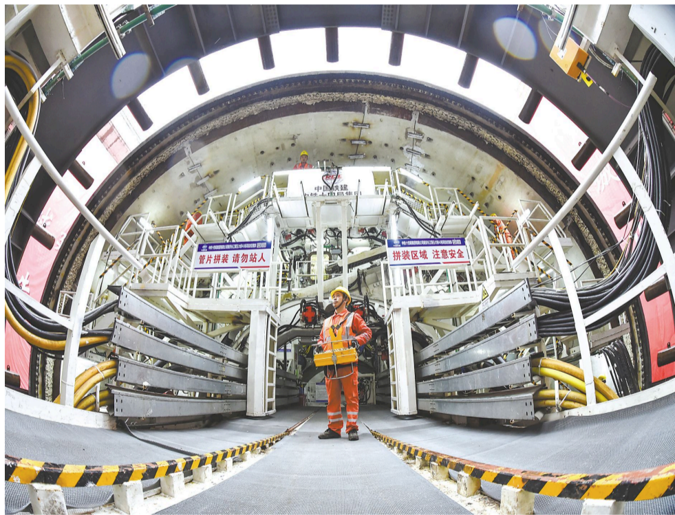
12月26日上午,随着“新时代号”盾构机刀盘徐徐启动,由中铁十四局集团承建的南京长江第五大桥A3标长江隧道工程胜利始发掘进,标志着开挖直径达15.46米的国内直径最大公路盾构隧道进入主体施工阶段。视觉中国供图
