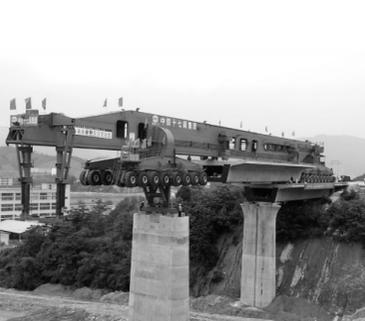
正在作业的由石家庄铁道大学国防交通研究所创新研发的“SLJ900/32流动式架桥机”。
