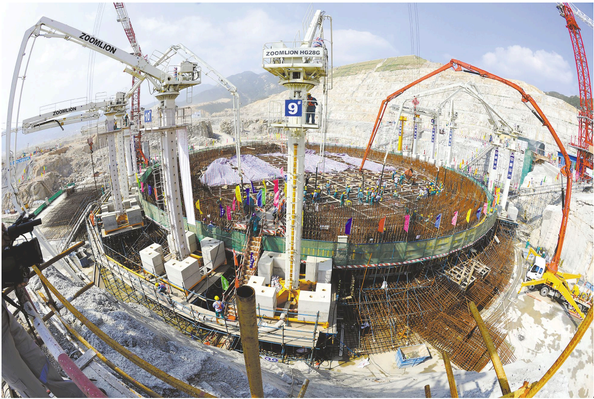
12月14日,中国广核集团与法国电力集团(EDF)联合宣布,广东台山核电1号机组已于北京时间12月13日17点完成168小时示范运行,具备商业运行条件,成为全球首台具备商运条件的EPR三代核电机组。 图为广东台山核电1号机组核岛施工现场。 新华社供图
