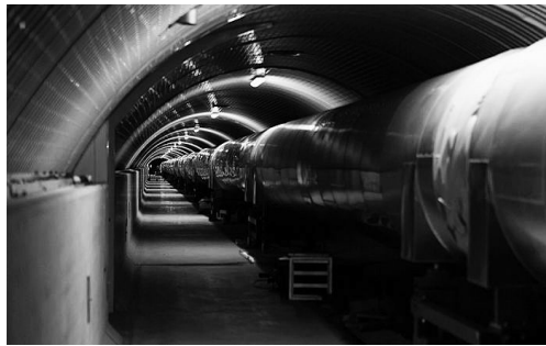
Virgo 探测器 3 公里长“手臂”中的真空管
