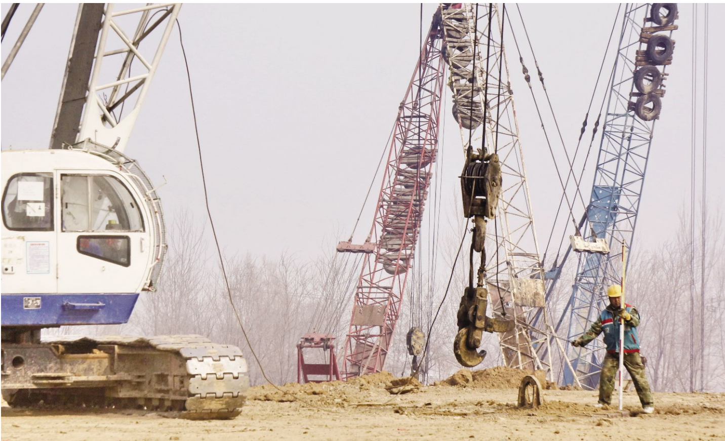
2月20日,工作人员在北京市延庆区世园会园区施工。当日,2019年中国北京世界园艺博览会的地下综合管廊工程开工建设,标志着北京世园会进入全面建设阶段。两年后,海内外游客将可在妫水之滨领略“万花之园”的风采。北京世园会园区位于北京市延庆区,横跨妫河两岸,距离八达岭长城约10公里,总面积503公顷。其地下综合管廊工程,是2017年北京城市建设重点工程之一,位于园柱区内,总长度3000多米。新华社记者李欣摄
