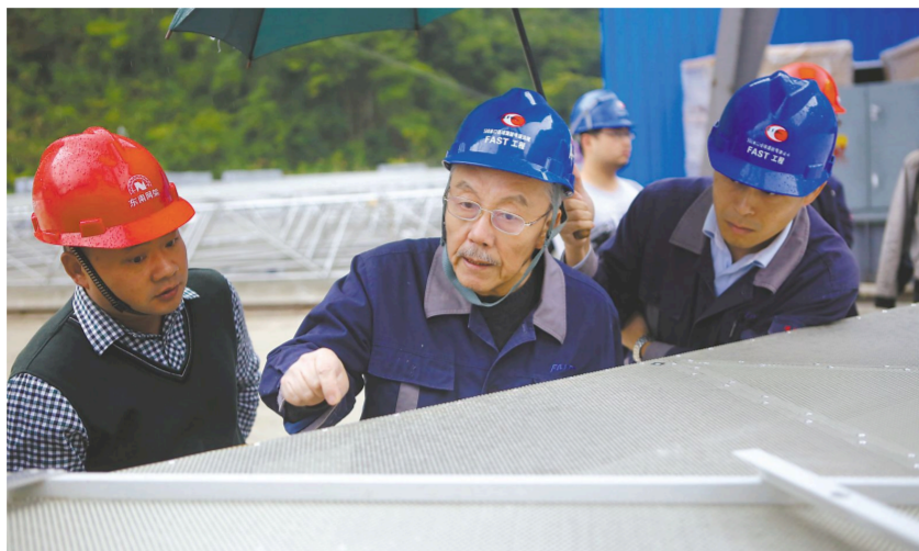
南仁东(左二)在大窝凼施工现场指导反射面单元拼装工作。
