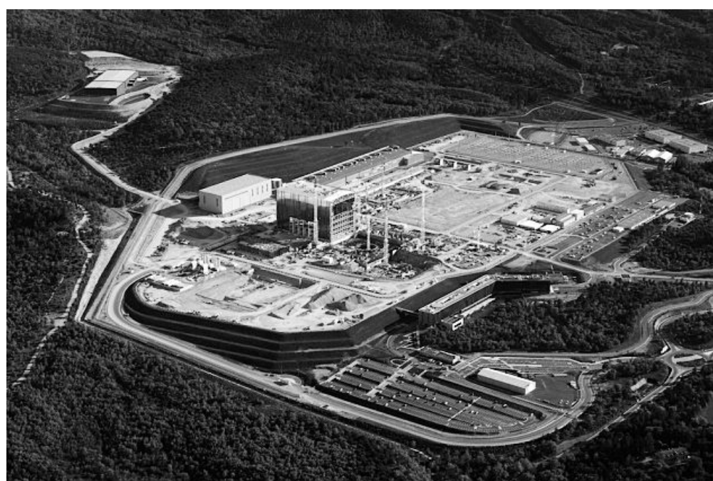
正在施工中的ITER项目
