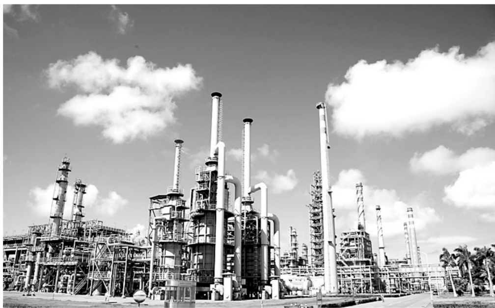
▲海南炼化厂区
