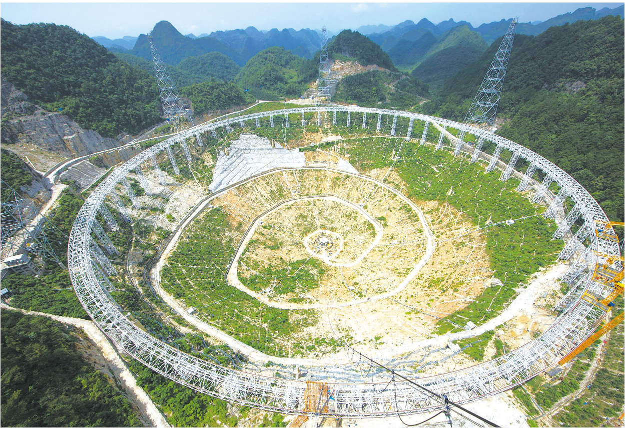
7月27日拍摄的正在建设中的500米口径球面射电望远镜。
