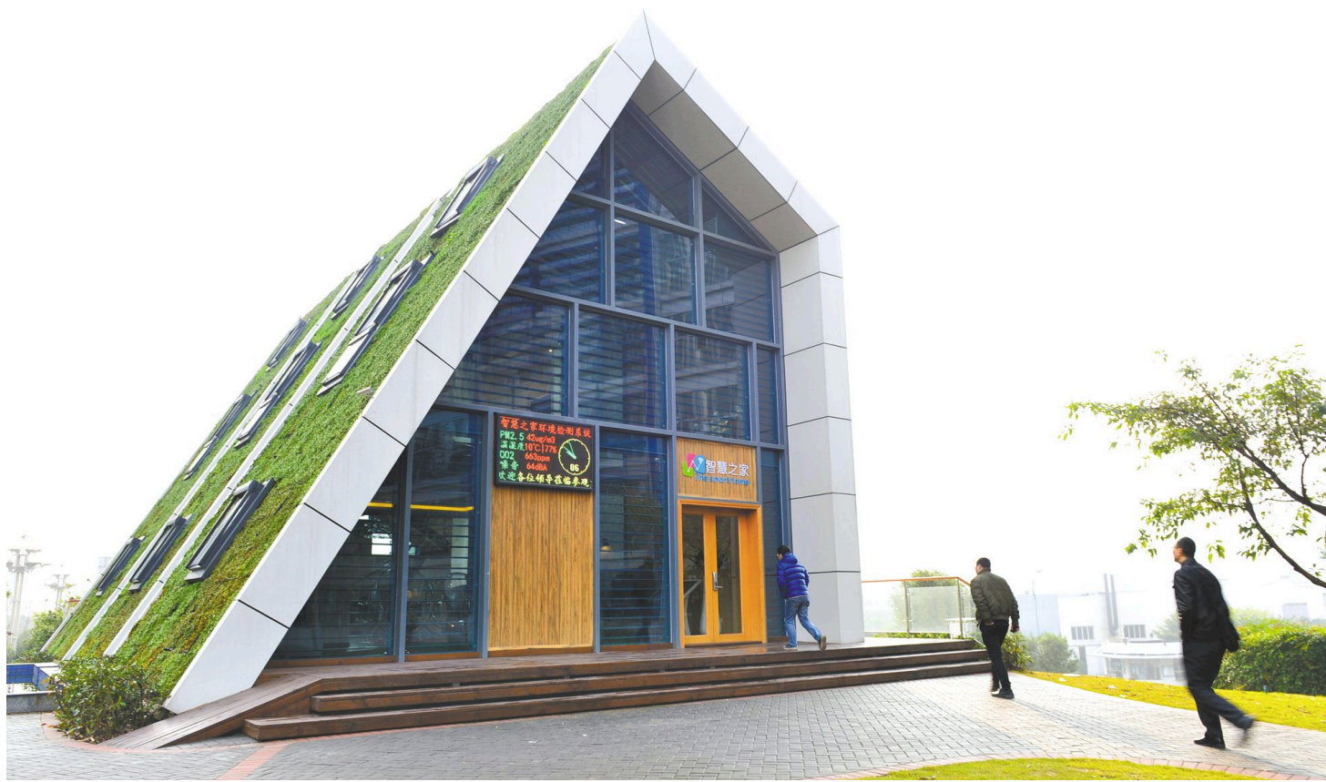
1月6日,重庆首个以低碳环保和物联网技术应用为主的“智慧之家”,正式落户重庆“国家物联网产业示范基地”。目前,该物联网应用示范项目已向公众免费开放。“智慧之家”是一栋钢结构的两层建筑,门外LED显示屏上显示着实时PM2.5、温湿度、二氧化碳浓度、噪音等数值。 新华社记者周会摄
