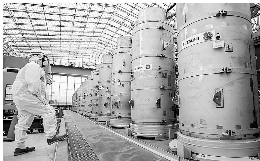
这个系统可去除福岛核电站污染水中的核素,但无法去除水中的氚。图片来源:EPA ORLANDO
