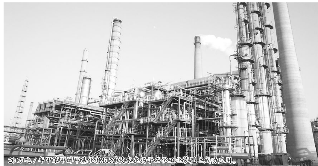
20万吨/年甲苯甲醇甲基化(MTX)技术在扬子石化工业装置上成功应用。
