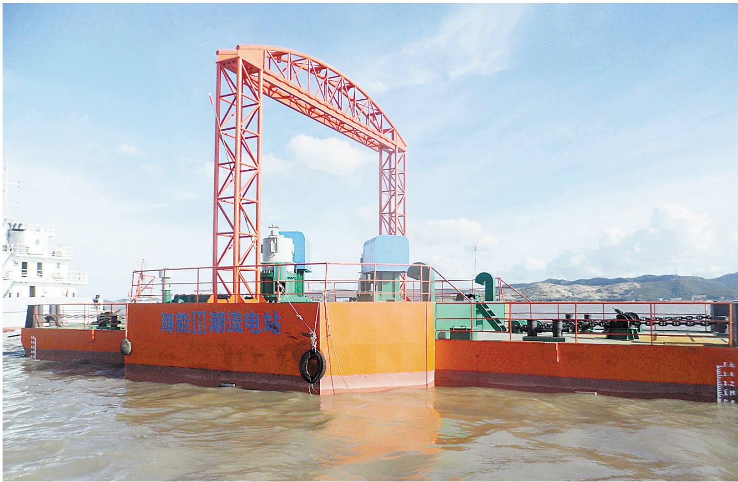
近日,全球最大发电容量的漂浮式立轴潮流能示范电站“海能Ⅲ”号在浙江岱山县龟山水道成功运行。据了解,“海能Ⅲ”号采用哈尔滨工程大学研发的总容量为 2×300 千瓦的双机组合十字型水轮机专利技术和漂浮式双体船载体设计。潮流能装置能实现自启动运行,发出的电力通过 500 米长的海底电缆送电上岸,可供官山岛上 30 余户人家日常用电。
