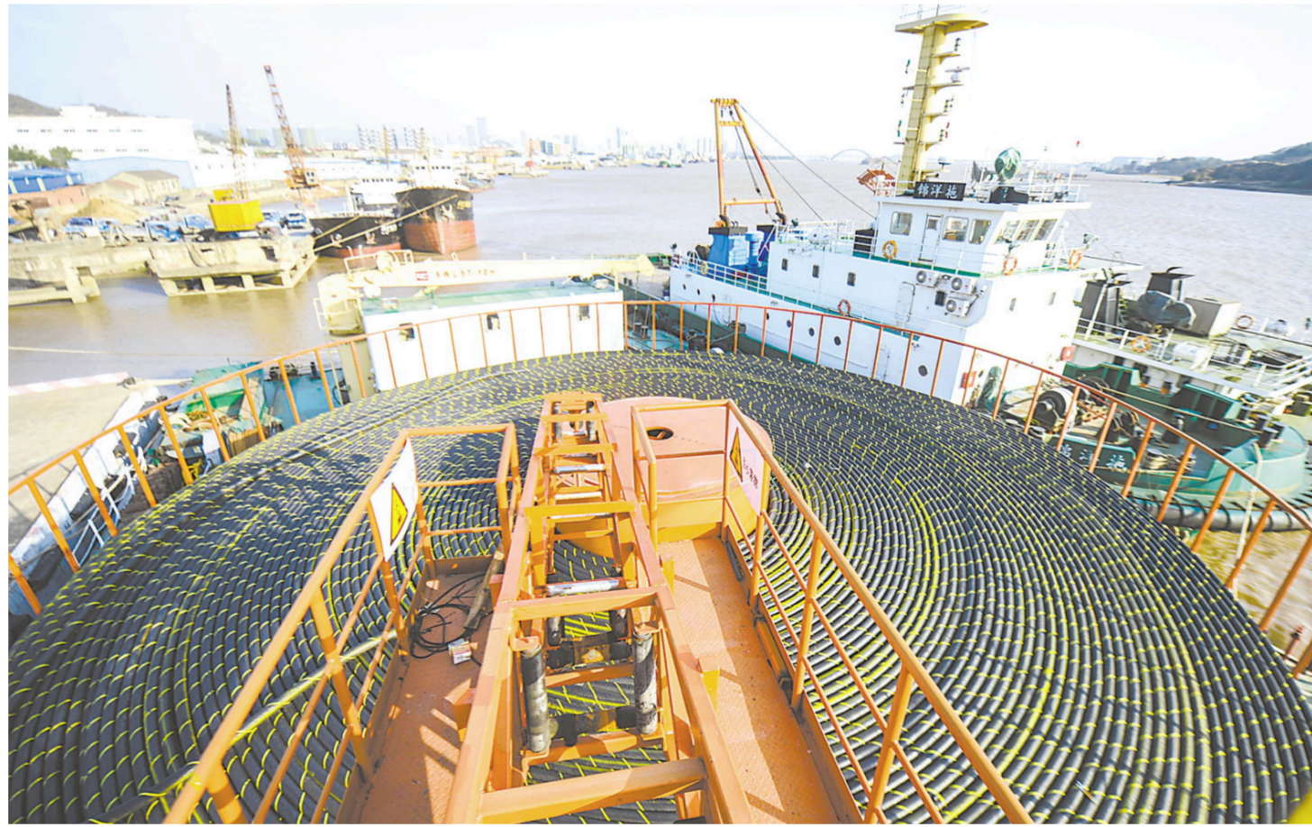
近日,国内最先进的电力海缆敷设船——舟山启明电力集团公司“建缆1”完成升级改造,历时10个月,在船上研制安装了一个载重量达2000吨、直径18米、每分钟0~18米无级变速的海缆施工转盘,能极大提高海缆敷设的安全性和效率。
