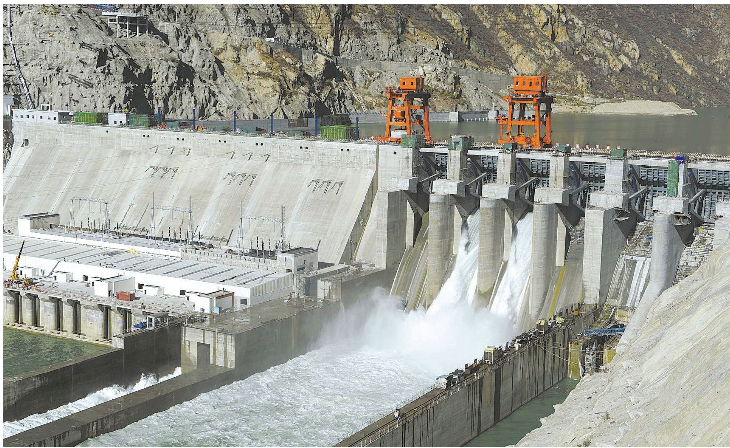
11月23日,西藏藏木水电站首台机组正式投产,这是我国在雅鲁藏布江干流上建设的第一座水电站,6台机组总装机容量51万千瓦。据了解,藏木水电站位于海拔3300米以上的雅鲁藏布江中游、山南地区加查县境内,由中国华能集团公司投资、建设和运营,设计年发电量25亿千瓦时,是西藏电力史上第一座大型水电站。新华社记者觉果摄
