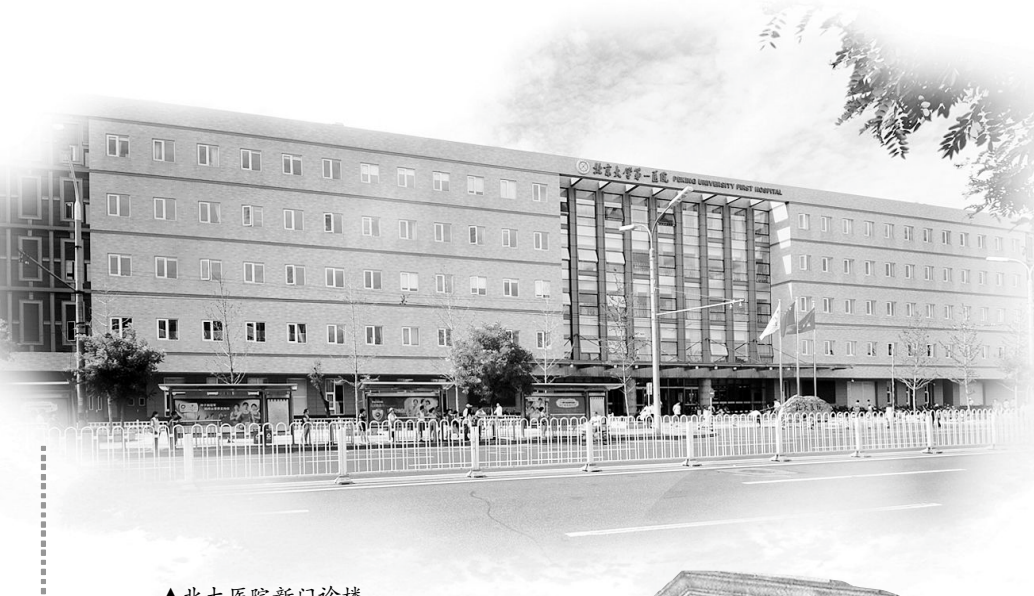
▲北大医院新门诊楼 ▶北大医院院内水准原点
