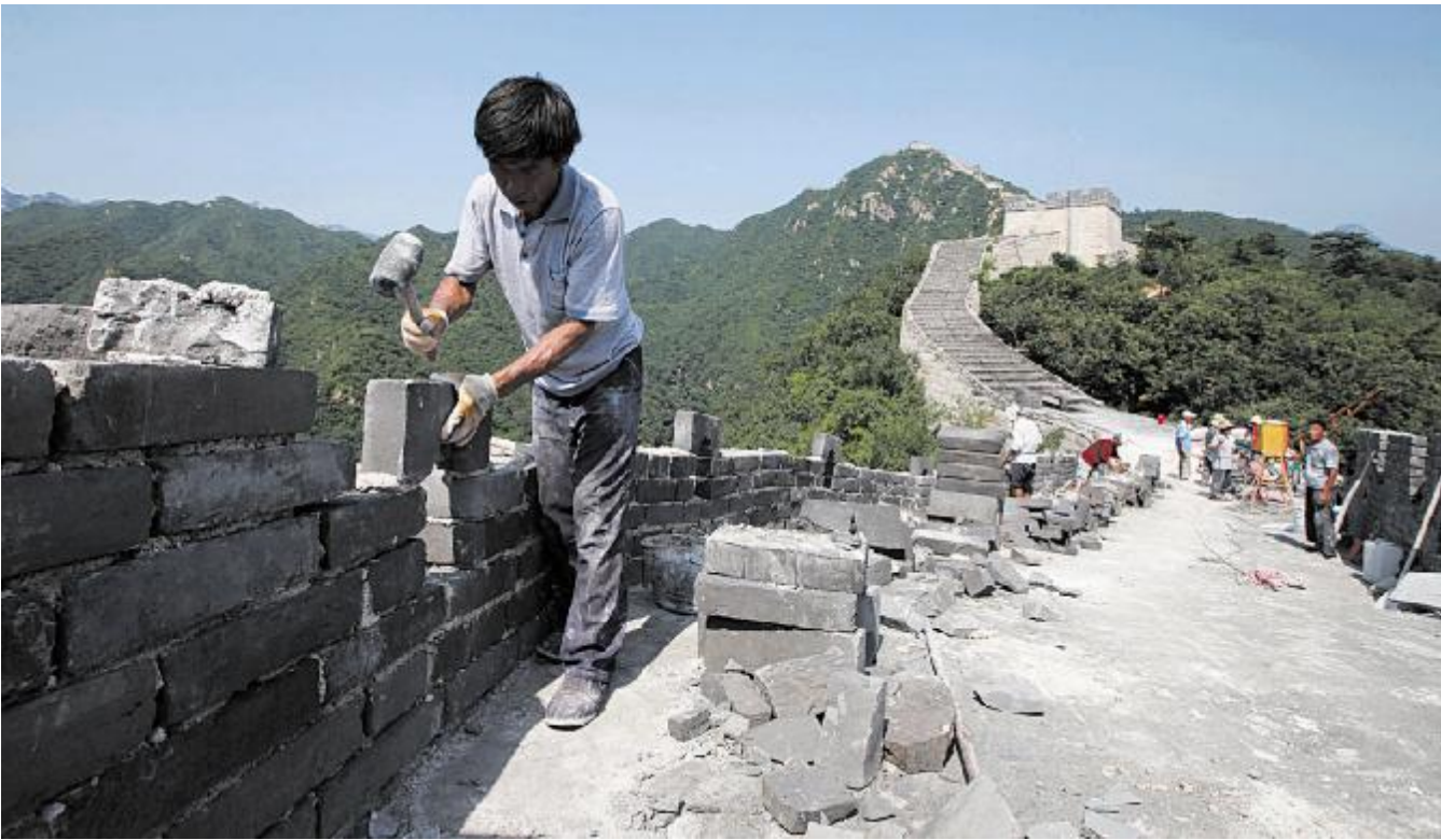
8月4日下午,施工人员在怀柔西水峪古长城进行修缮。 西水峪古长城始建于明代,此次修缮部分总长960米,在严格保障结构安全以及原有风貌的前提下进行恢复性修缮,修缮后将达到对游客开放攀登的标准。预计修缮工程将于今年10月底完成,届时经过专业部门验收后有望对外开放。 卜向东摄(新华社供图)
