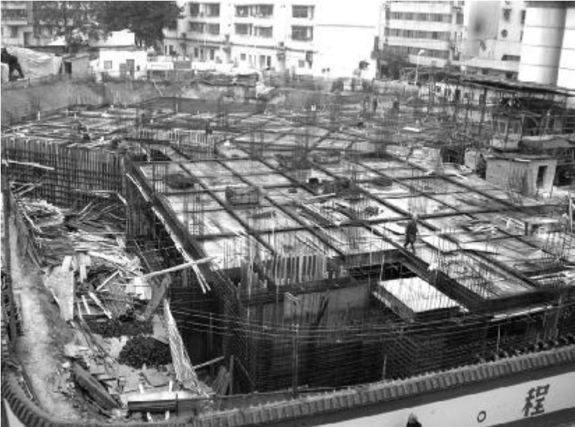
某县级医院正在如火如荼地建设新大楼。
