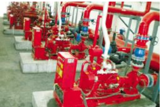
上海宇航机库应用三业数字定压柴油机消防水泵 (本版图片由企业提供)
